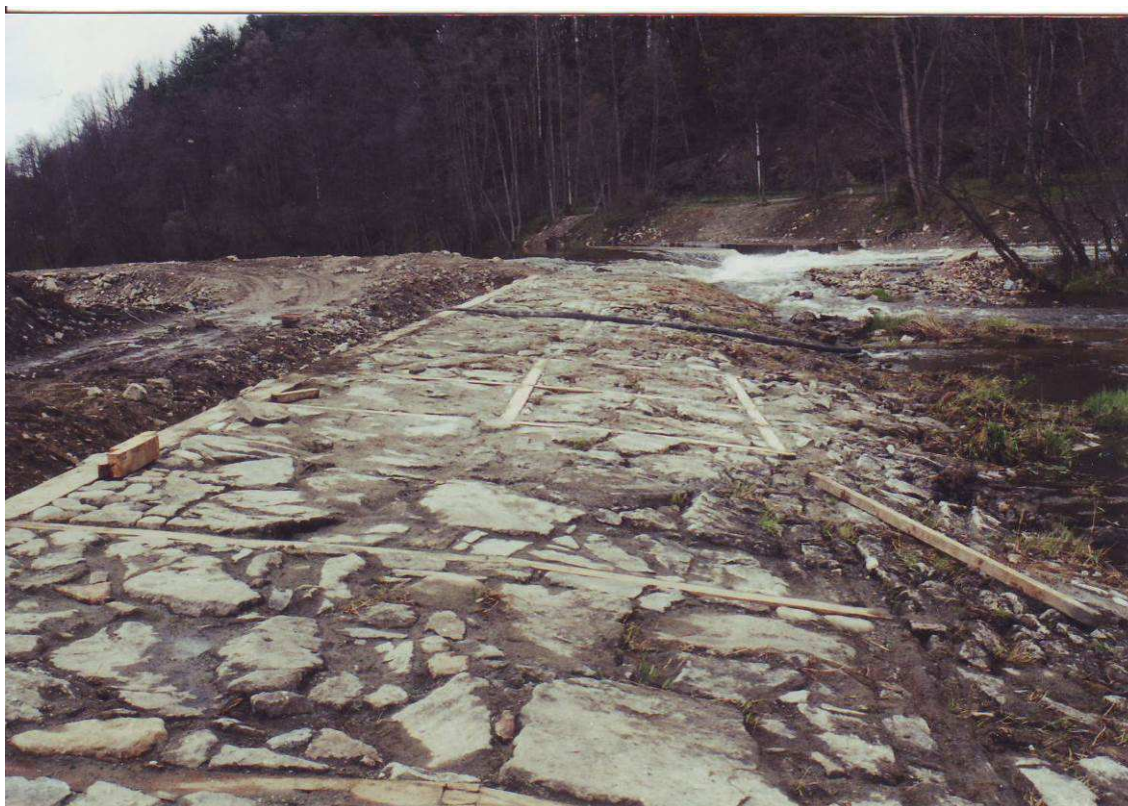
Obr. 11. Oprava jezu v roce 2000 –přelivná plocha u zbylé části jezu s částečnou opravou - výměna výdřevy
