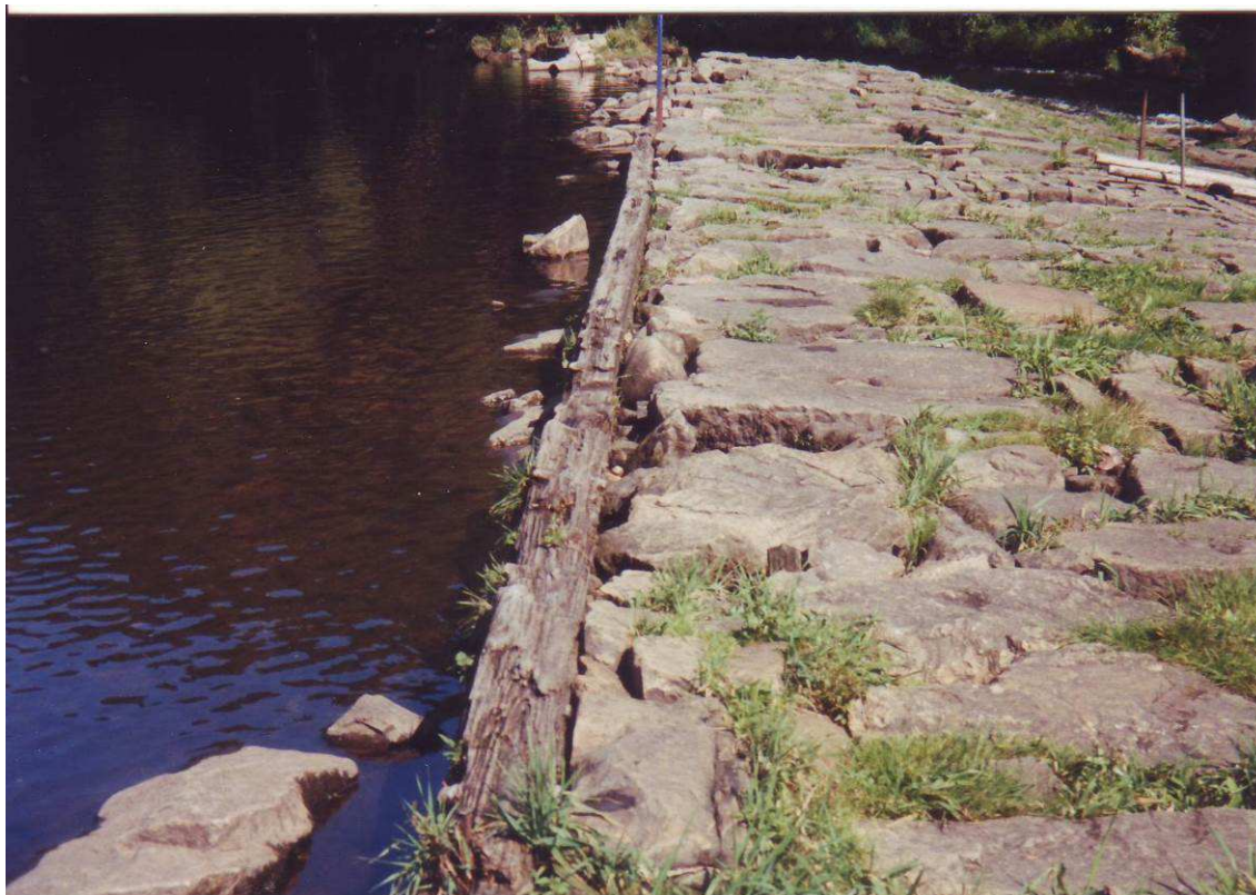
Obr. 2. Stav jezového tělesa před opravou v roce 2000 – horní štětová stěna
