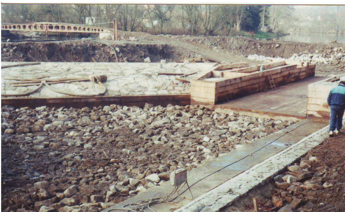
Obr. 6. Oprava jezu v roce 2000 – vorová propust s opravenou částí jezového tělesa
