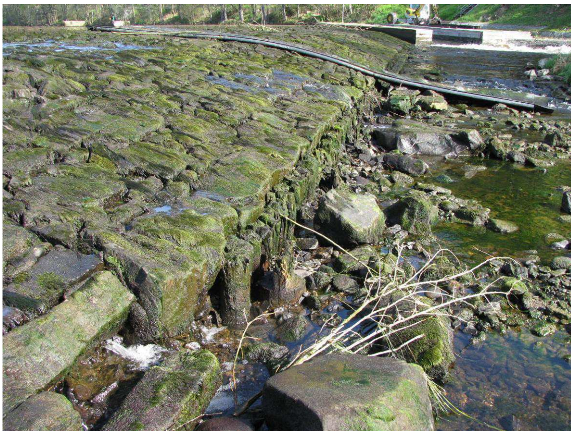
Obr. 14. Pohled na přelivnou plochu jezového tělesa s vyhnílou spodní štětovou stěnou – současný stav
