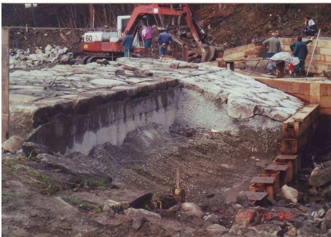
Obr. 4. Oprava jezu v roce 2000 – oprava 15 m jezového tělesa současnou technologií
