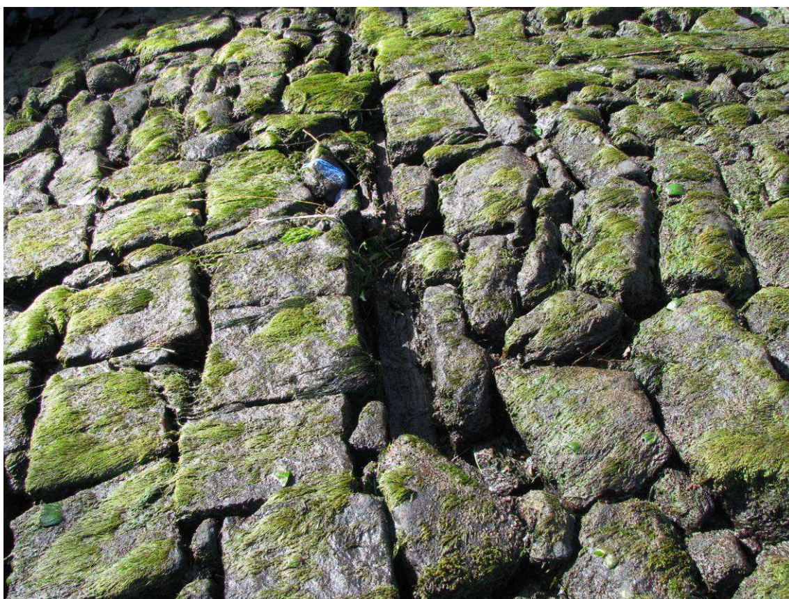
Obr. 13. Pohled na přelivnou plochu jezového tělesa s vyhnílou výměřevou – současný stav
