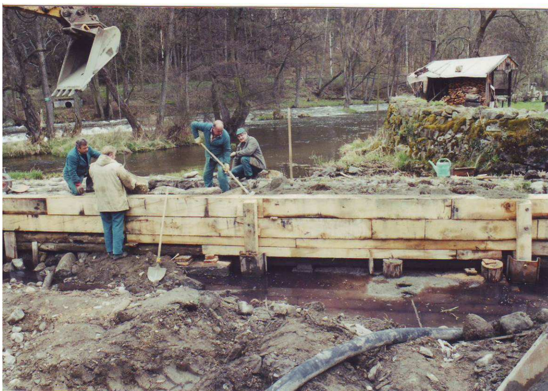
Obr. 9. Oprava jezu v roce 2000 – horní štětová stěna u zbylé části jezu s částečnou opravou
