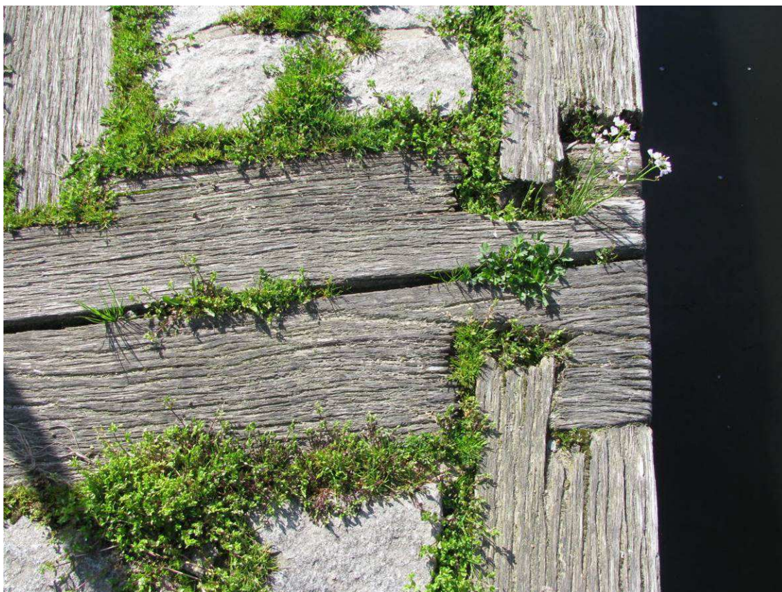
Obr. 18. Detail poškození srubové konstrukce pilíře vorové propusti – současný stav
