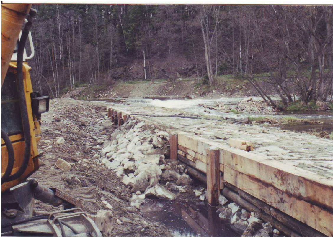
Obr. 8. Oprava jezu v roce 2000 – horní štětová stěna u zbylé části jezu s částečnou opravou
