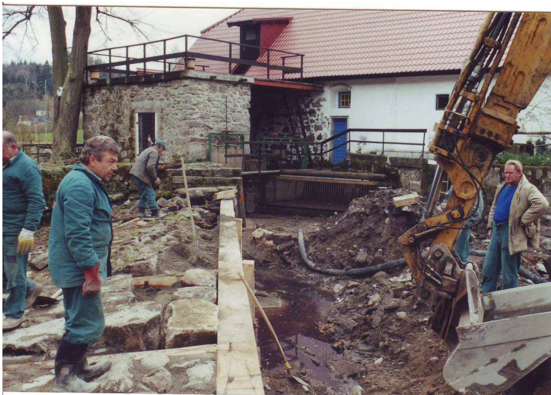
Obr. 10. Oprava jezu v roce 2000 – horní štětová stěna a část přelivné plochy u zbylé části jezu s částečnou opravou
