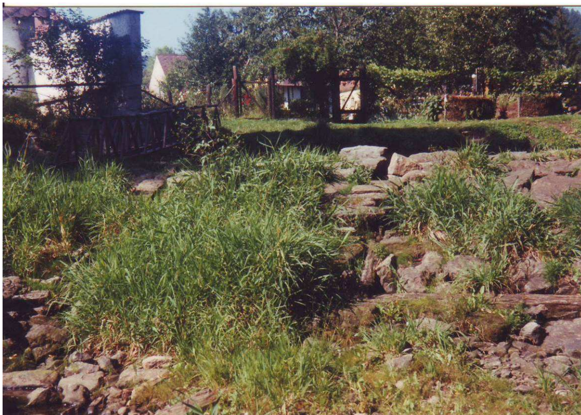
Obr. 3. Stav jezového tělesa před opravou v roce 2000 – přelivná plocha u MVE
