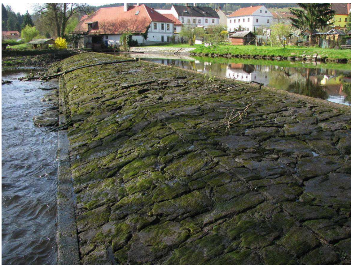
Obr. 15. Pohled na část přelivné plochy opravenou v r. 2000 podle současných technologií – současný stav
