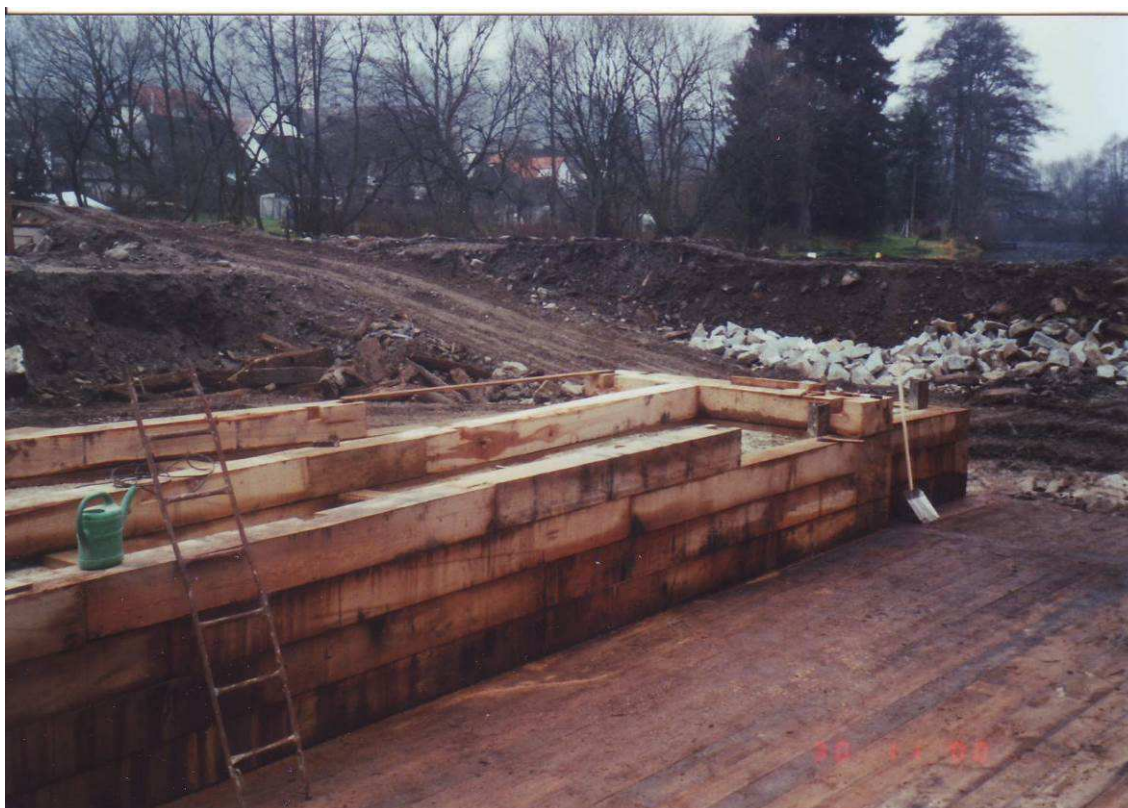
Obr. 5. Oprava jezu v roce 2000 – oprava pilíře vorové propusti
