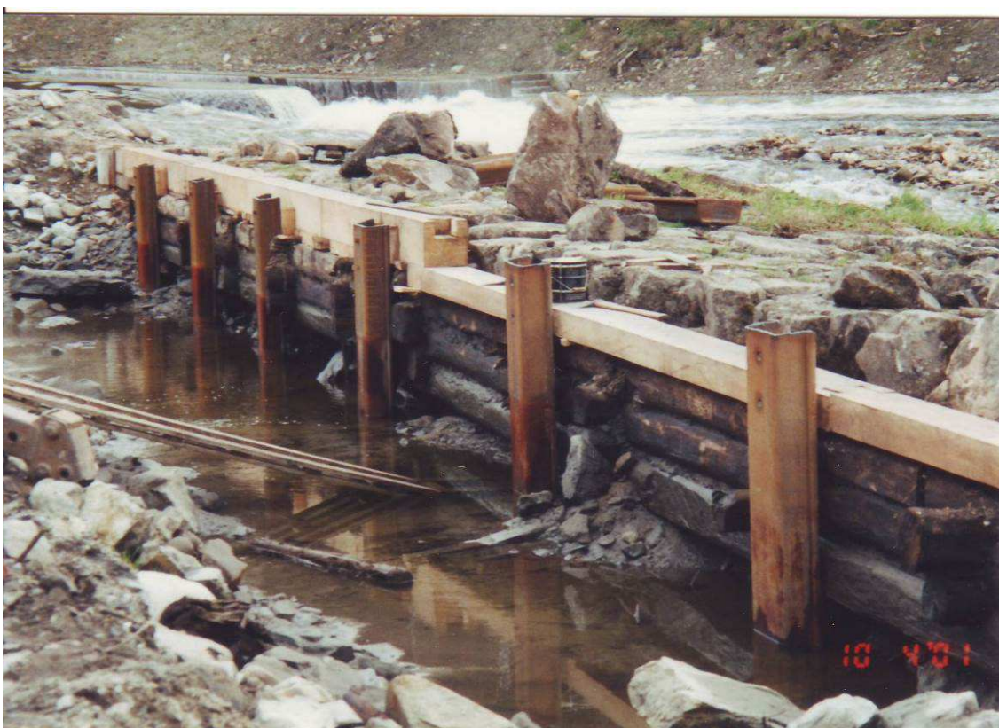
Obr. 7. Oprava jezu v roce 2000 – oprava horní štětové stěny u zbylé části jezu s částečnou opravou
